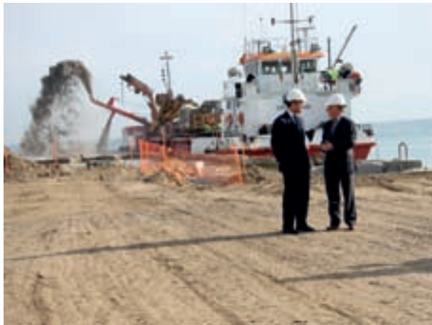
El Presidente de la Generalitat visita las obras de la Ampliación Norte del Puerto de Valencia
