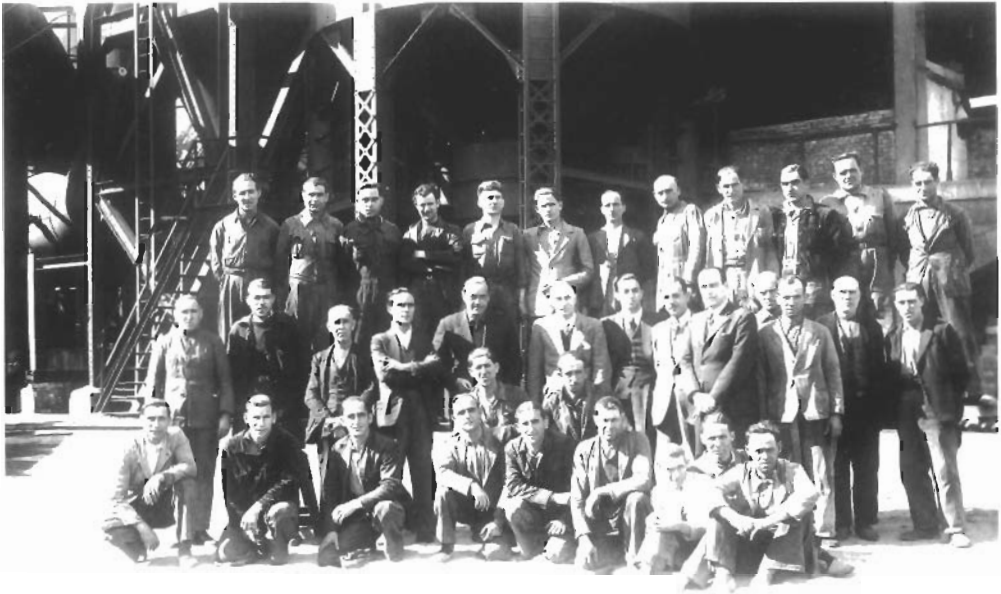
Grupo de obreros con la dirección al finalizar una reparación del Horno Alto, c. 1944 (Archivo Fundación P.P.H.I.S.)
