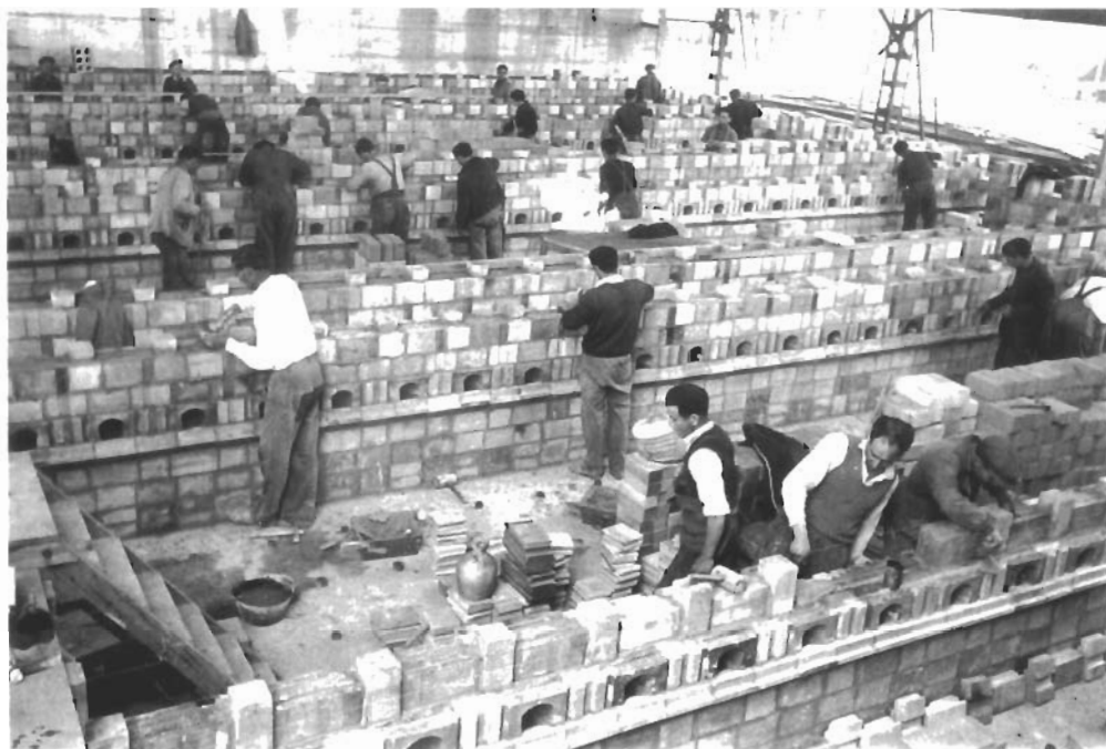
Obras de ampliación de las nuevas baterías Otto de los hornos de cok, 1953 (Archivo Fundación P.P.H.I.S.)
