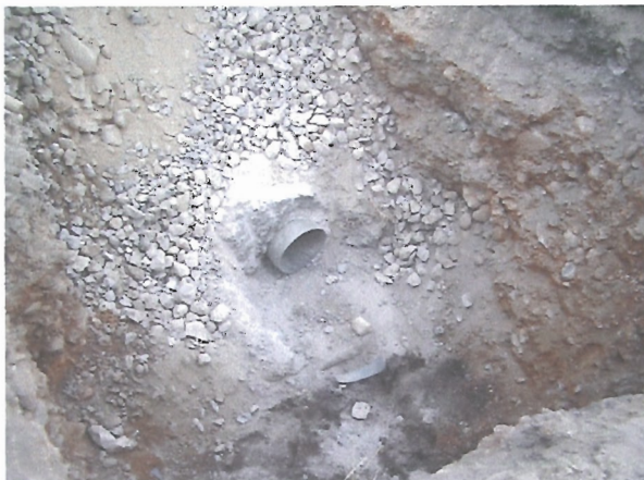
Pasamuros para las acometidas al interior de la rotonda.
