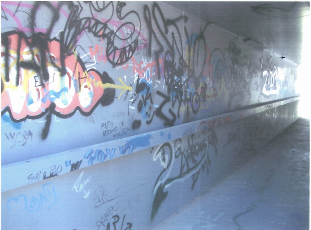
Interior de la rampa de acceso a la base del horno.
