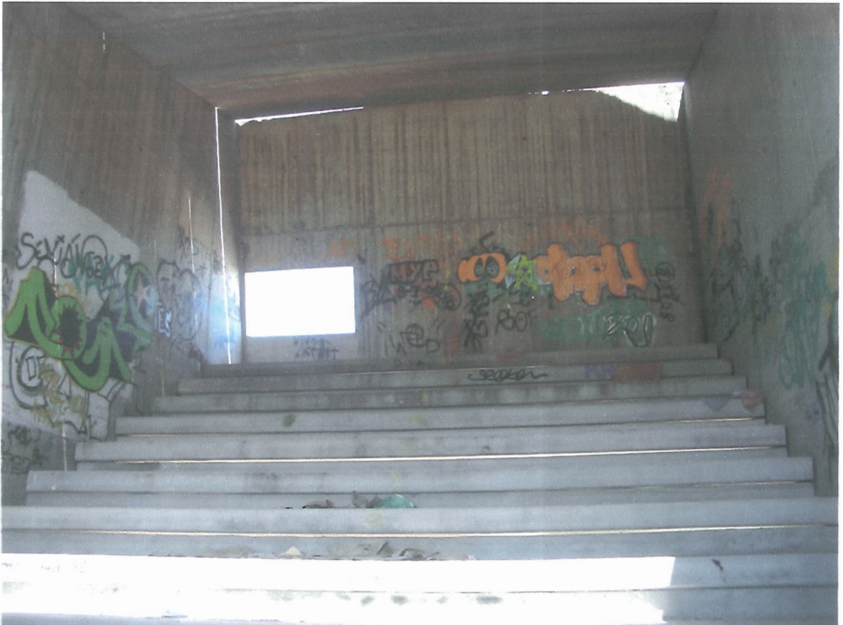
Estado actual del interior del pabellón de recepción.
