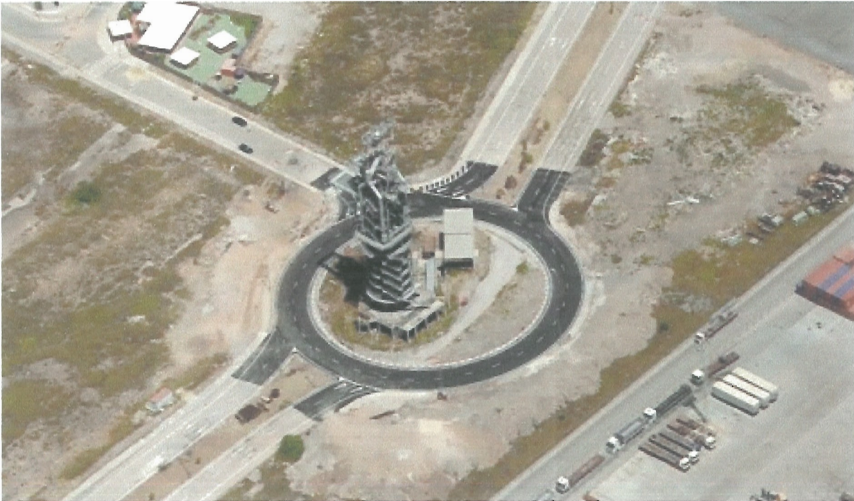
Vista aérea del horno
