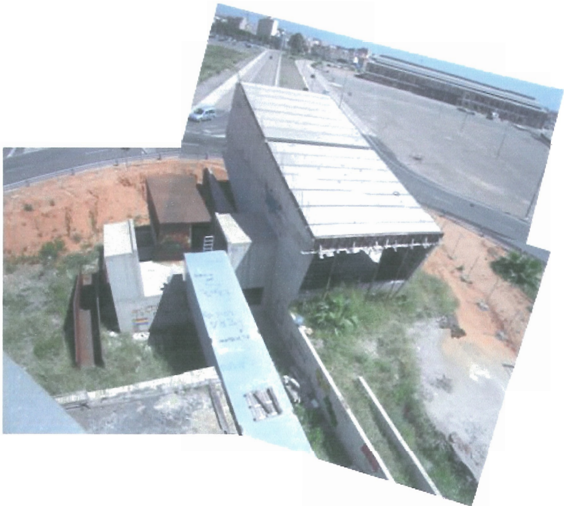
Vista del pabellón de recepción desde el horno.
