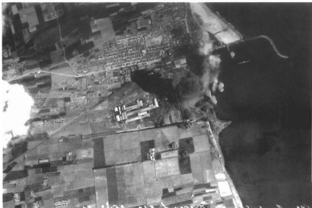
Bombardeo sobre el Puerto de Sagunto, 25 de febrero de 1938. En esta ocasión los daños fueron en las instalaciones portuarias y al buque inglés Bramiden. (Archivo Municipal de Valencia. Aviazione legionaria delle Baleari. Foto nº 76)
